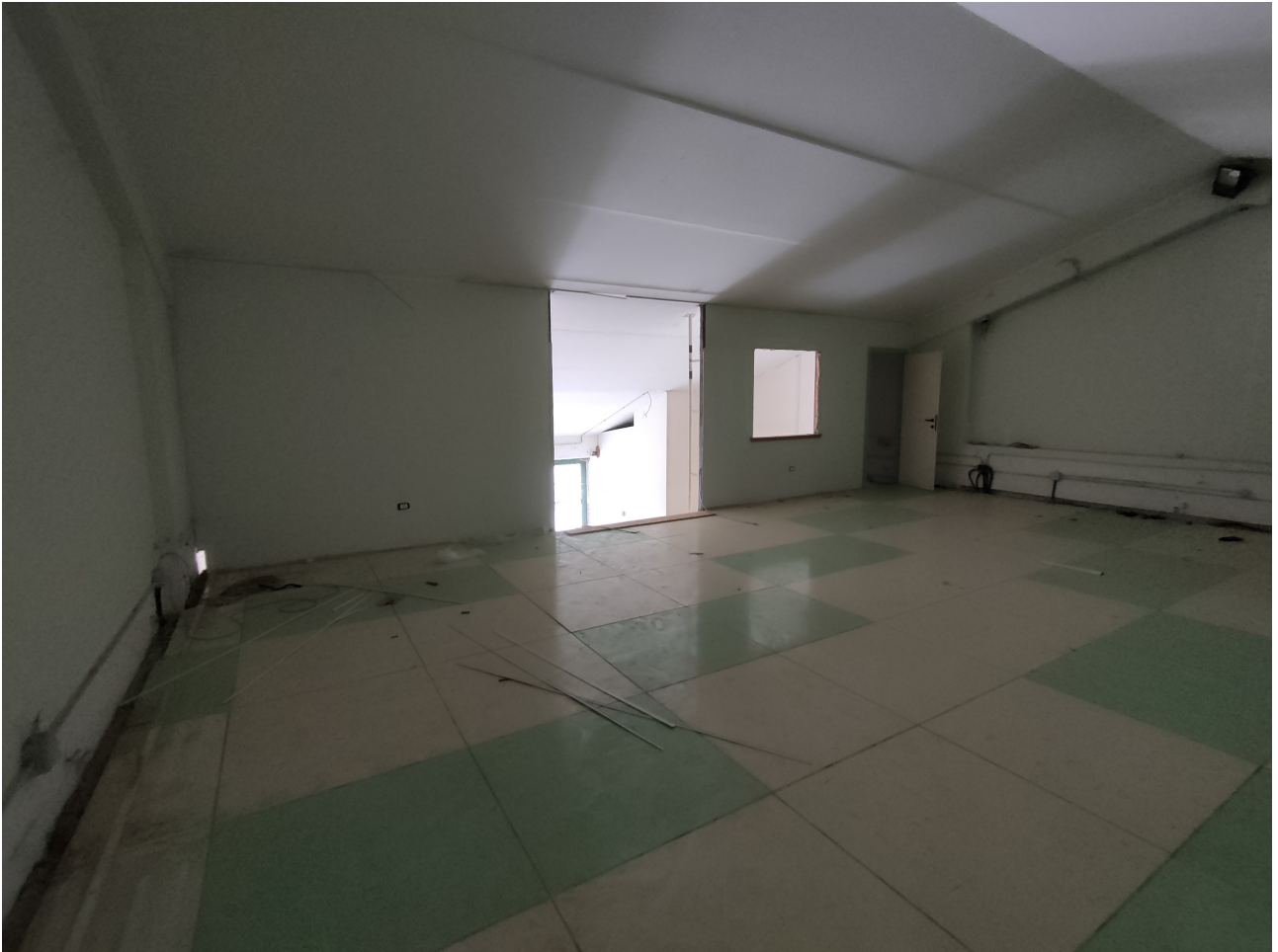
FOTO 7 – SOPPALCO E APERTURE SU LOCALE PIANO TERRA
