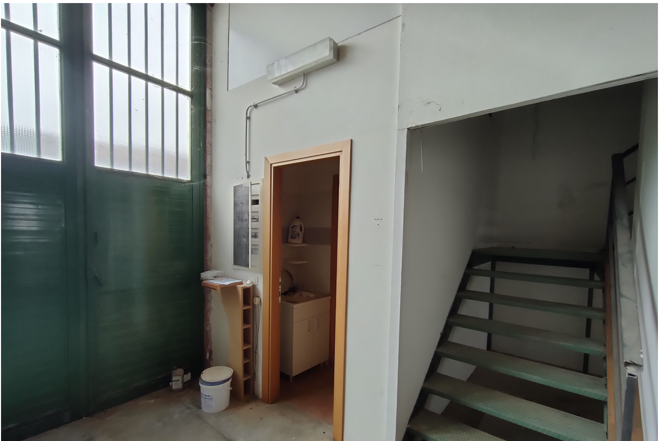
FOTO 4 – SCALA ACCESSO SOPPALCO E ACCESSO SERVIZIO
